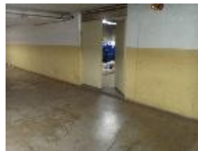
ACCESO A SALA GGEE
